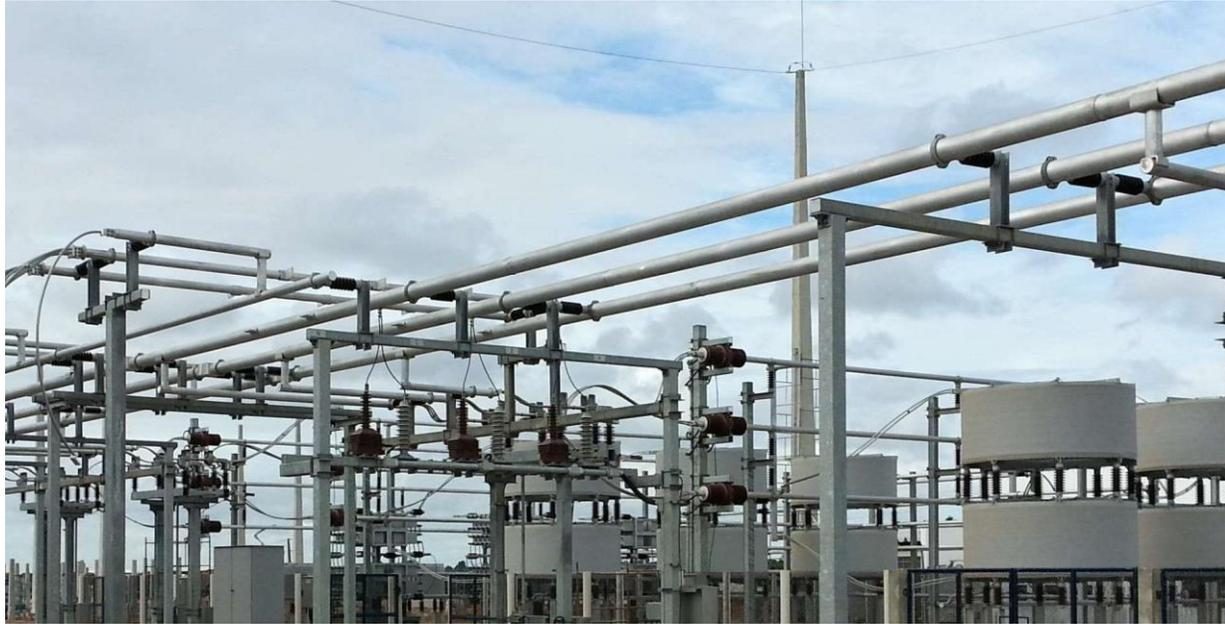
**Figura 2.2 Barras colectoras de subestación eléctrica de 230 kV.**
